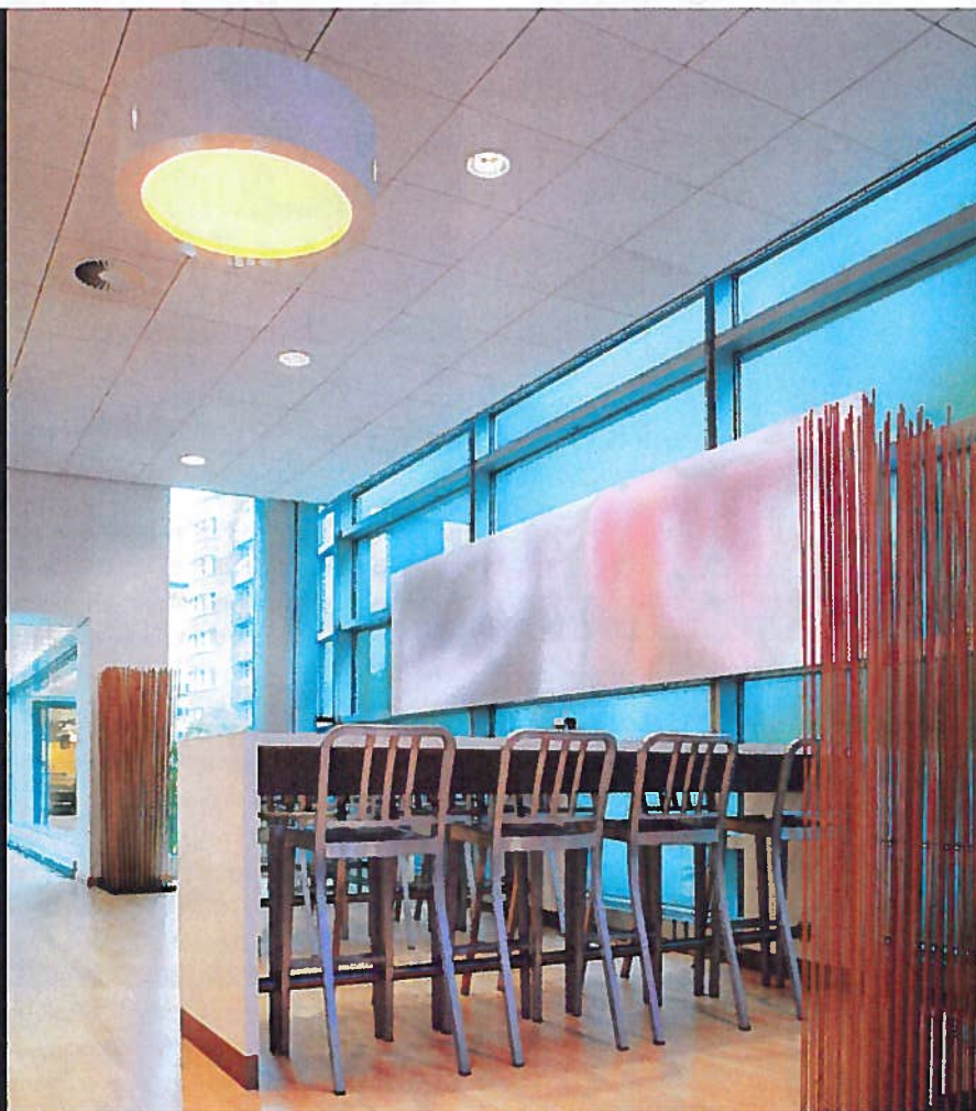
De panelen in het Philips-restaurant hangen met staaldraden aan de houten koven van het plafond. (Foto: BLD AV Media)
